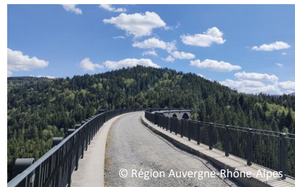
Garde-corps sur le viaduc de la Recoumène
